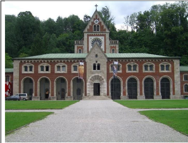
Das Haupt-Brunnhaus der Alten Saline...
